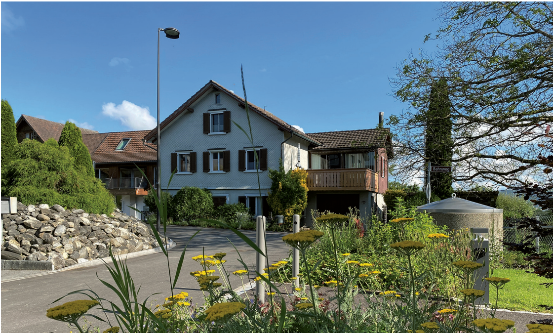
Als viertes Uzwiler Dorf wird Algetshausen Ende Juni komplett auf Unterflurbehälter (UFB) umgestellt. Der UFB am Bahnweg ist einer von mehreren im Dorf.
